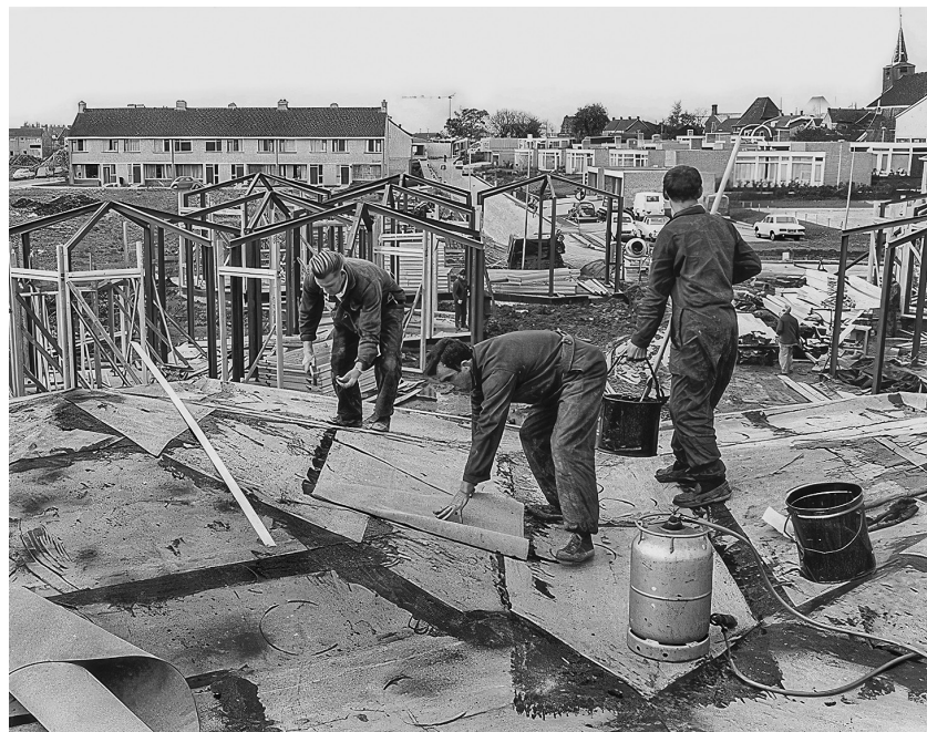
Het winkelcentrum in aanbouw.
